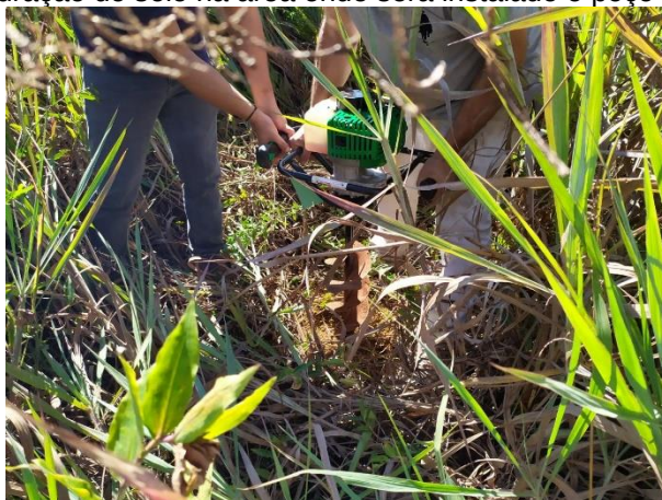
Figura 04: Perfuração do solo na área onde será instalado o poço para aquicultura.
